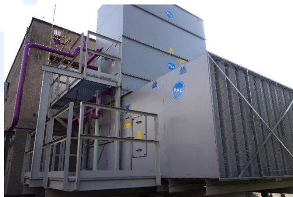
Foto 12: Odpařovací kondenzátor čpavku – u strojovny chlazení
